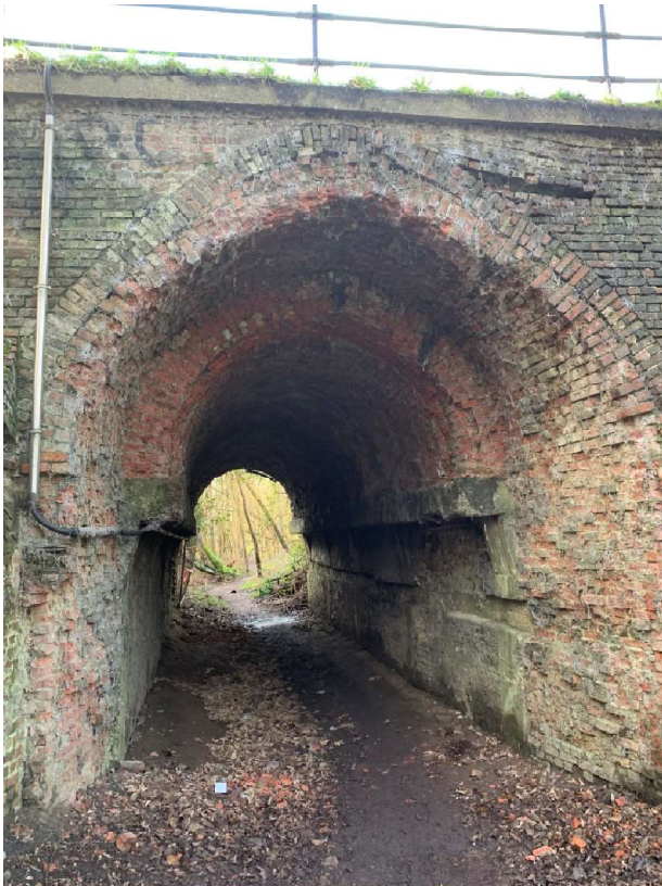
Figuur 3: zicht op de tunnel A onder de Kapelstraat (Greenspot, 13 januari 2023).
