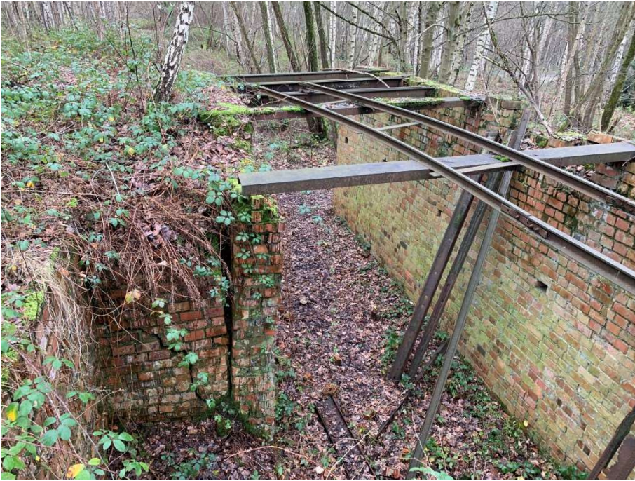
Figuur 5: zicht op relict C (Greenspot, 13 januari 2023).
