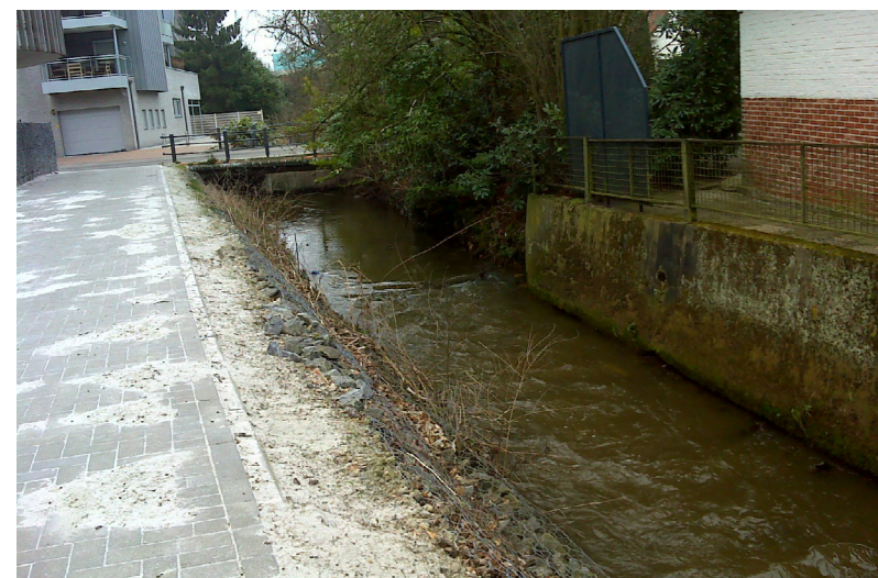
keermuur die voor opstuwing zorgt
