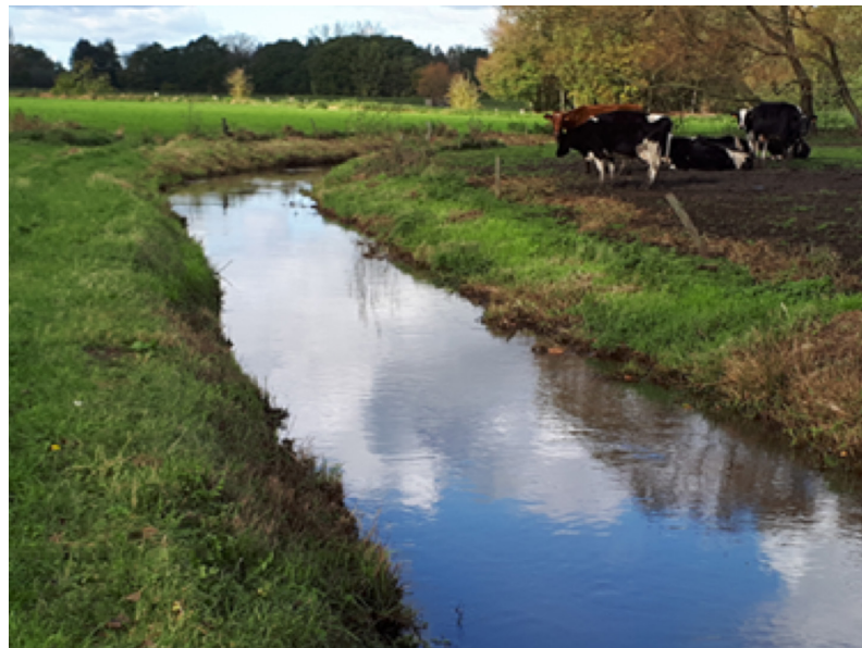
bestaande toestand van de Oude Dommel in wachtbekken
