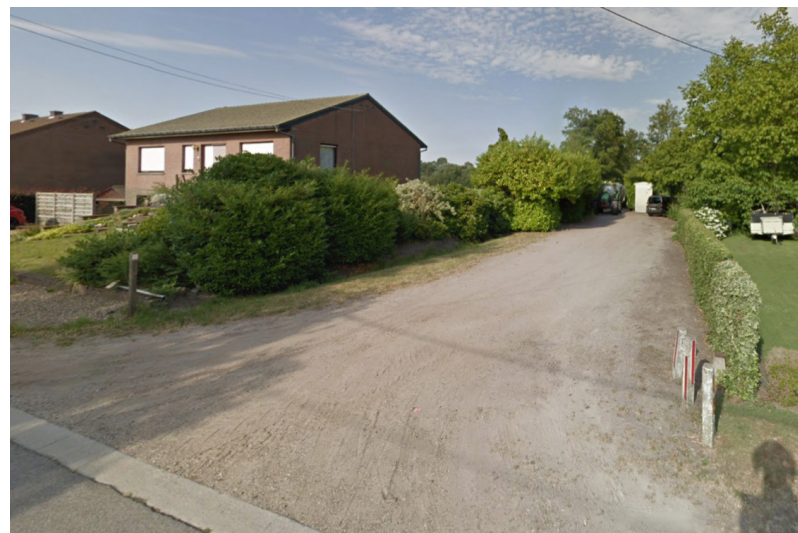
bestaande toegang Heesakkerstraat
