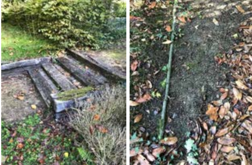
Figuur 3.3-64: Houten trappen, begin van pad omheen pastorietauin
