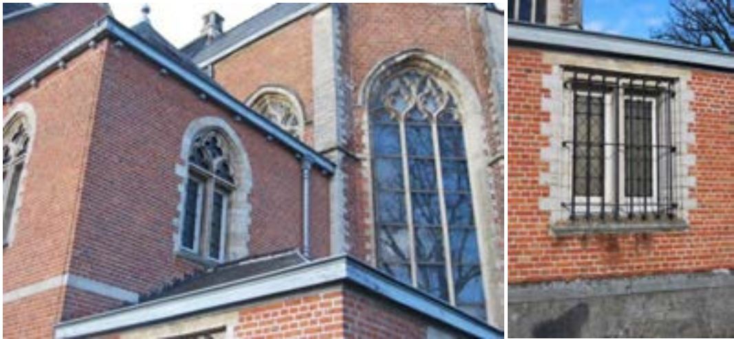
Figuur 3.2-6: Vensters in de oostgevel (2018) – Julie Conradi
