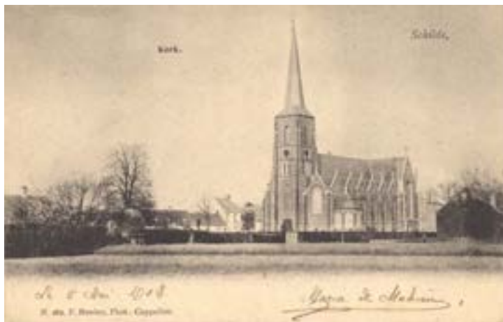
Figuur 2.2-8: Zicht zuidwesten (1903) - via Heemkundige Kring Scilla
