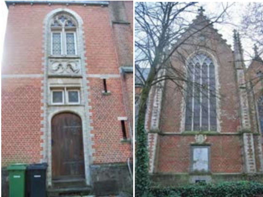
Figuur 3.2-4: Schrijnwerk in de aanbouw (links) en spitsboogvenster in transept (rechts) (2018) – Julie Conradi
