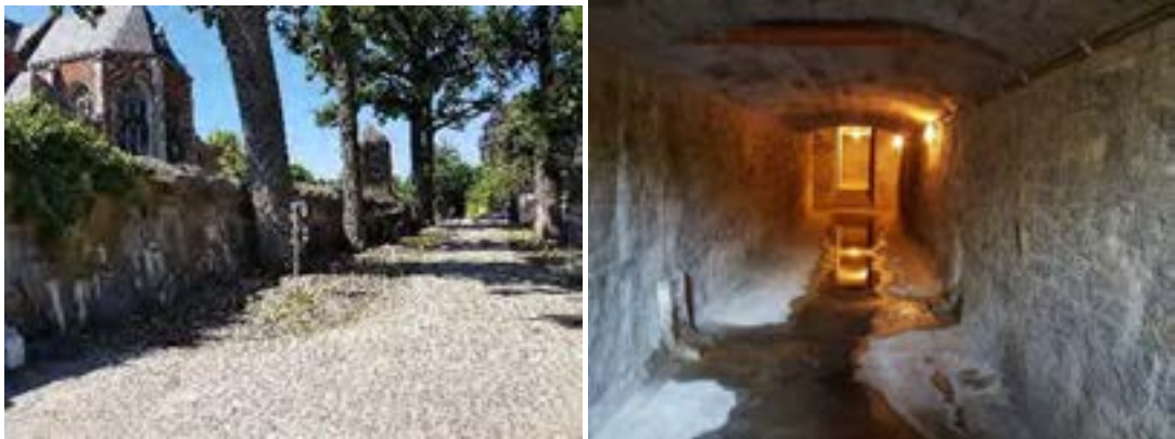
Figuur 5.3-21: buitenkant (links) en binnenkant (rechts) monumentale muur
