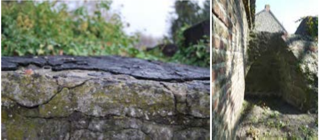
Figuur 3.2-22: Toestandsopnames monumentale muur: verweerde bitumen en scheuren in muur (2019) – Julie Conradi
