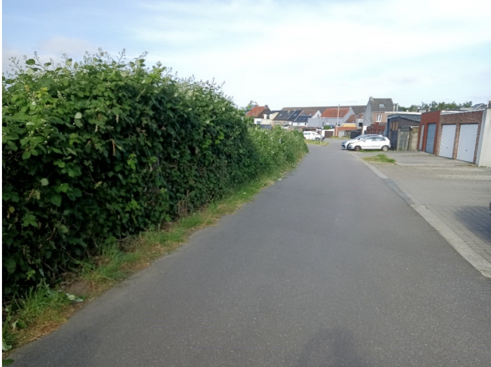
Foto 3: Observatiepunt 2: Omheining intact (30/05/2023)
