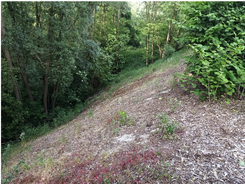
Foto 8: Observatiepunt 5: Staat van betonnen wand is onveranderd, er zijn geen omgevallen bomen die afdekking kunnen hebben beschadigd (30/05/2023).
