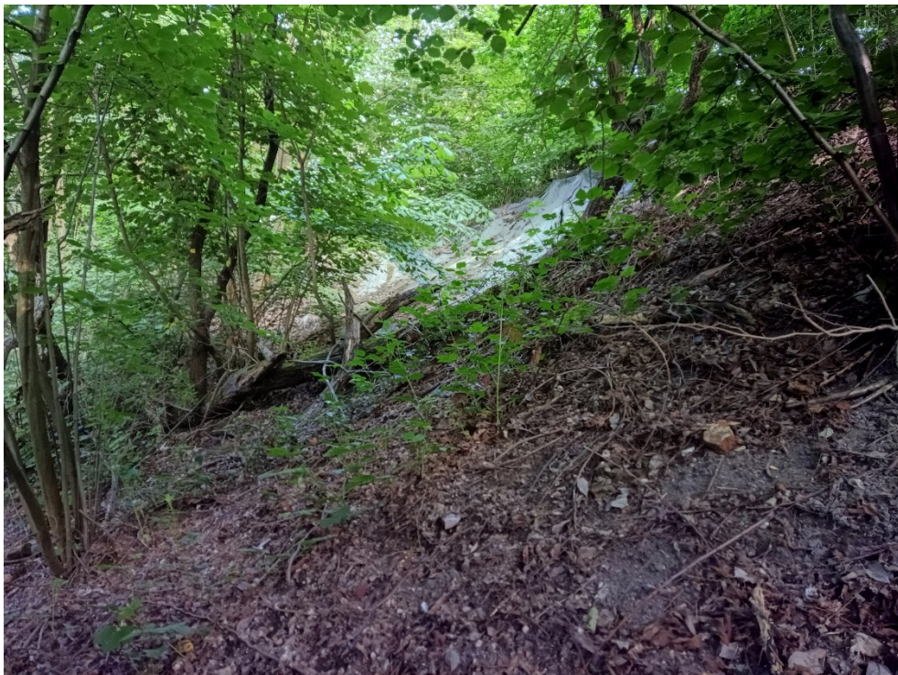
Foto 10: Observatiepunt 6: Toegangspad tot afdekzeil zeer moeilijk terug te vinden door begroeiing (30/05/2023)
