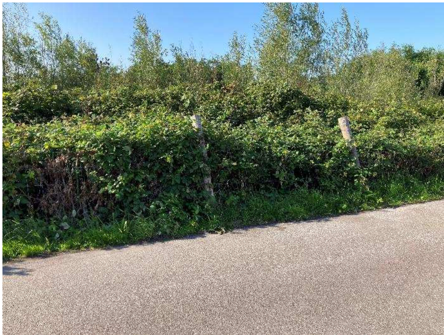
Foto 17: Reeks van 3 wankle houten palen door verrotting
