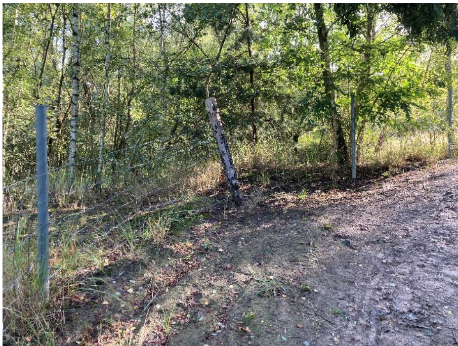
Foto 13: Beschadigde houten paal
