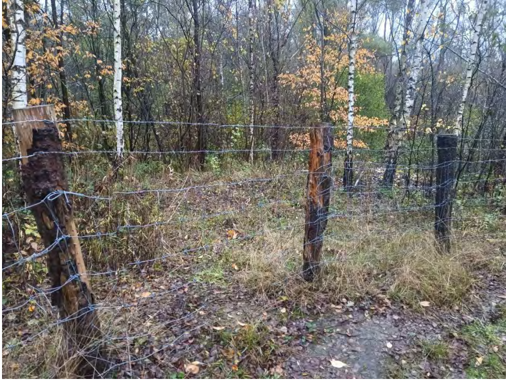
Foto 35: Beschadigde omheining nabij Observatiepunt 13 (13/11/2023)
